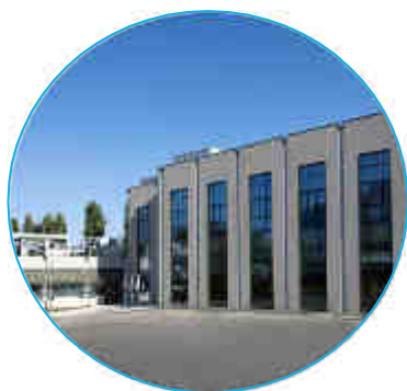
Nuovo Fabbricato NFI
